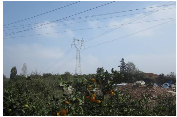
220kV 葛点二回线路沿线情况
