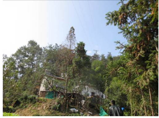
110kV 雁建线线路沿线情况
