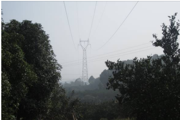
220kV 郭楼二回线路沿线情况
