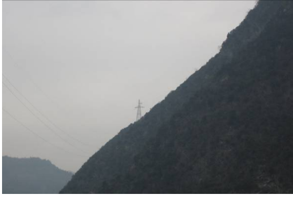
110kV 雁座线线路沿线情况
