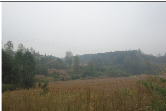
220kV 兴山变 220kV 出线侧
