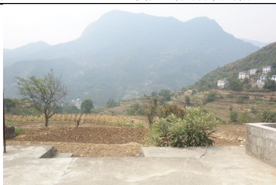
兴万线 \pi 兴山变 110kV 线路（下长坪小区附近）
