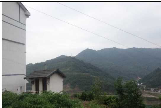
兴山~平邑口 110kV 线路（跨越香溪河附近）
