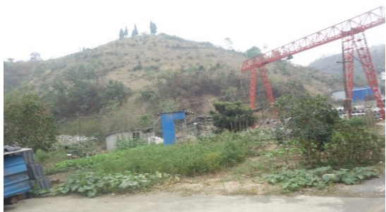
兴山~黄花变 220kV 线路（姜家湾村附近）
