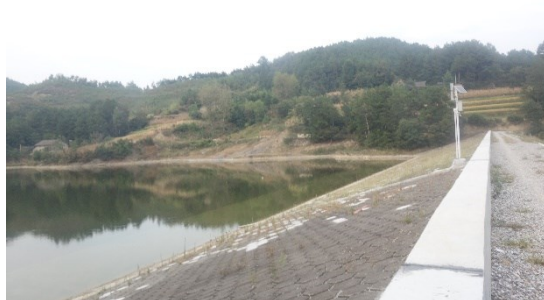
兴山~平邑口 110kV 线路（跨越拱桥湾水库）
