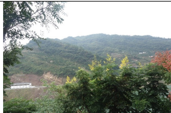
兴山~秭归 220kV 线路（跨越香溪河附近）
