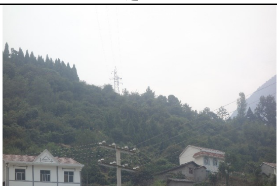
110kV 兴万线改造工程（麦仓村附近）
