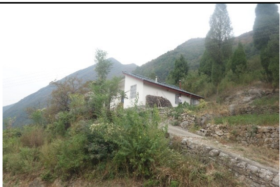
兴山~平邑口 110kV 线路（青华村附近）
