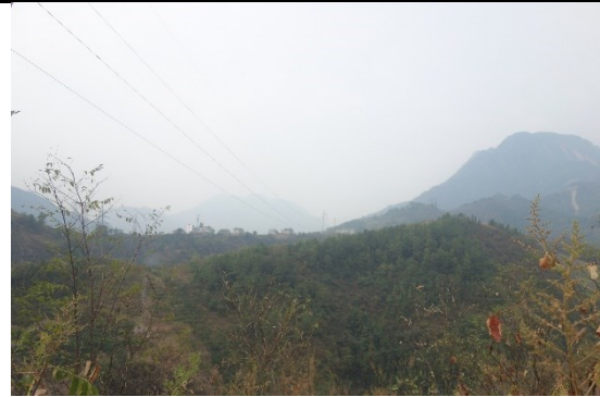
110kV 兴万线改造工程（万家岭变出线段）
