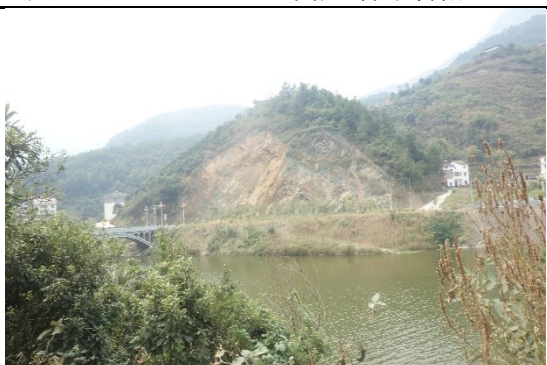
兴万线 \pi 兴山变 110kV 线路（跨越香溪河附近）
