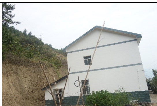
110kV 兴万线改造工程（腰子坪附近）
