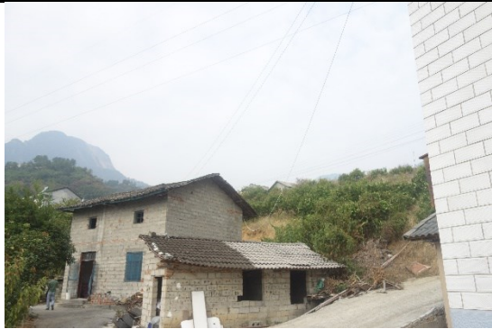
110kV 兴万线改造工程（大坪小区附近）
