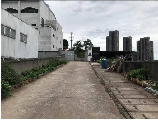
变电站进站道路
