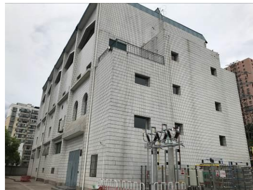
厦门路 110kV 户内变
