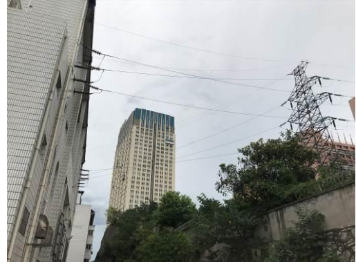
变电站 110kV 出线侧
