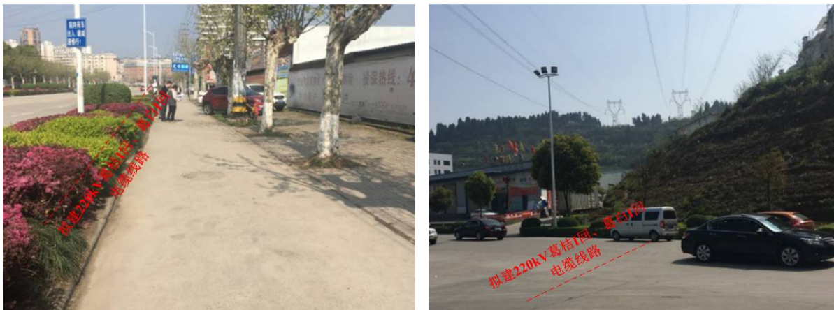
图 1-1 拟建 220kV 葛桔 I 回、葛白 I 回电缆线路沿线情况
