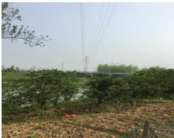
线路跨越渔洋河处
