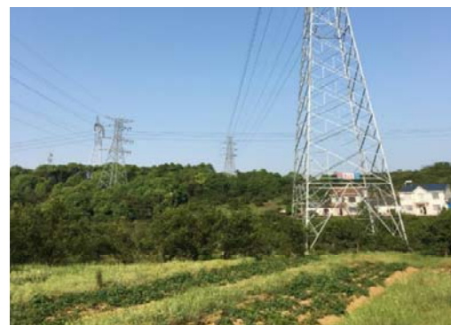
塔基处绿化恢复情况（远景）
