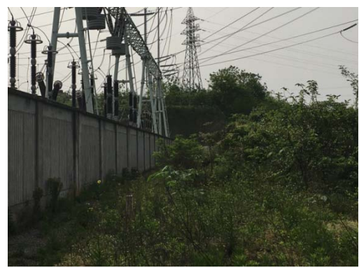
站址周边绿化恢复情况
