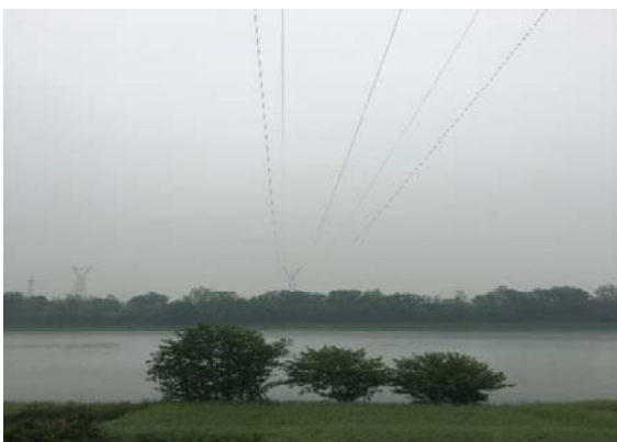
线路跨越清江处
