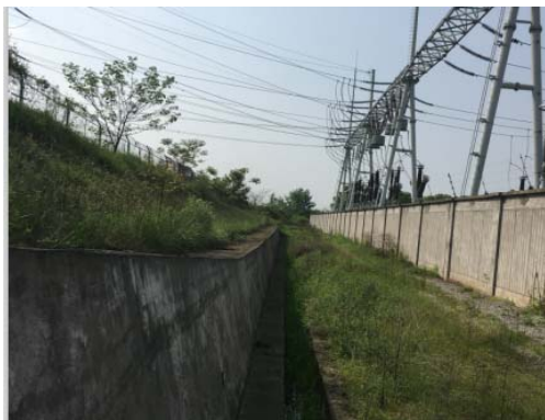
站址外挡土墙及排水沟
