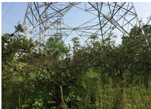
塔基处绿化恢复情况（近景）
